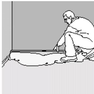
Versare il riempimento nell'area compresa fra le due guide di riferimento in quantità non superiore a quella da staggiare, evitando di calpestare il granulare già steso.
