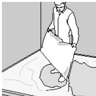
Livellare il riempimento solo con la staggia e non costipare mai il granulare mediante compressione. Non calpestare il riempimento staggiato a livello. Preparata una superficie di superficie superiore alla dimensione della lastra, posare il primo strato di lastra. Procedere per strisce in modo tale da non calpestare il granulare e perdere il livello.
